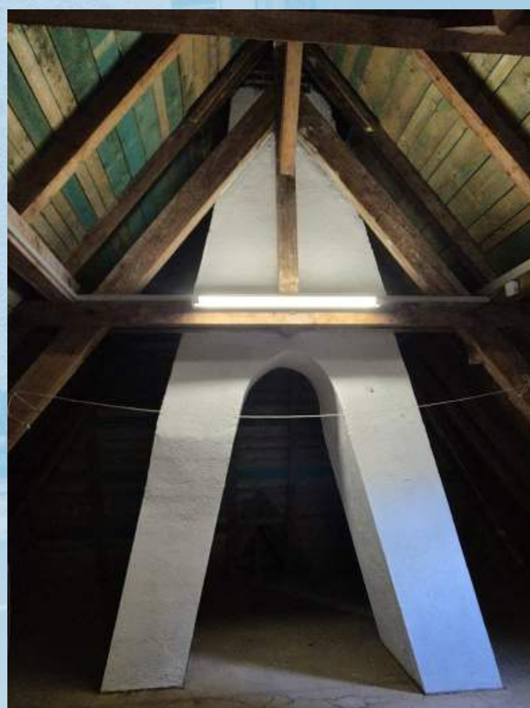
Speicher, Kamine unter dem Dachstuhl
