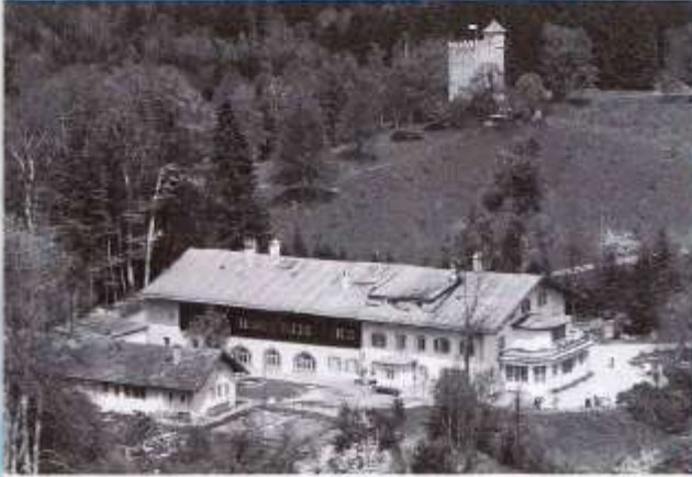
Luftaufnahme der Villa Hohenfried um 1960 (!): links das später baufällig abgerissene Gärtnerhaus, oben der an eine Burg erinnernde Wasserturm mit Rotkreuzfahne
